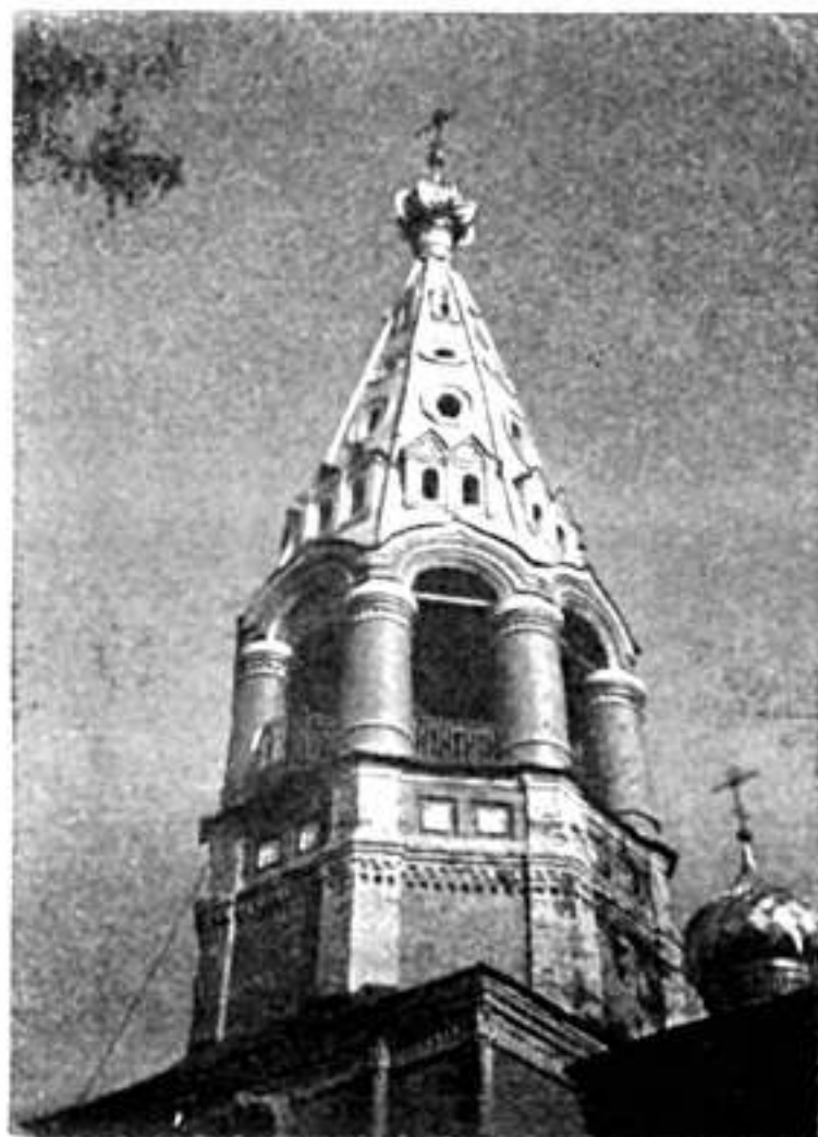
Колокольня Иоанно-Богословской церкви.
