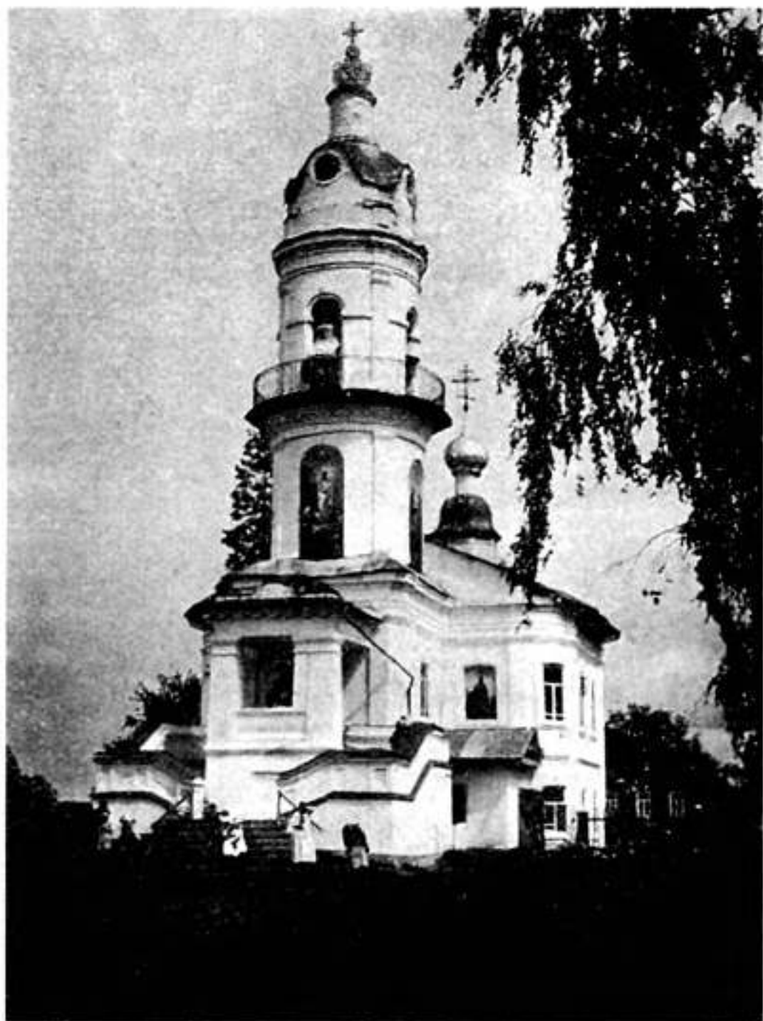
Алексѣвская церковь близъ Запрудни.
