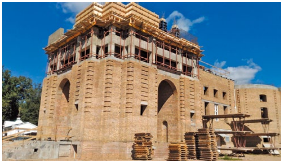
12 августа 2017 года. Строящаяся колокольня Костромского кремля.
