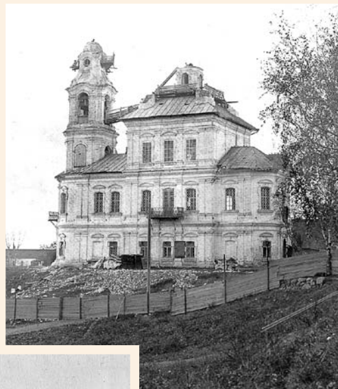
Разборка Петропавловской церкви. Фото середины тридцатых годов XX века.
