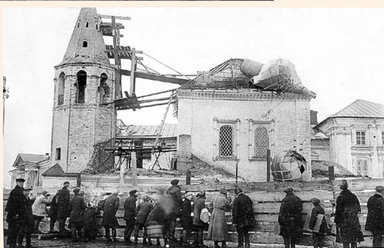
Разборка Воскресенской церкви на площадке. Фото 1930 года.
