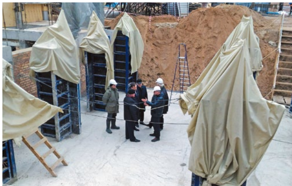
27 октября 2016 года. Губернатор Костромской области С. К. Ситников на строительной площадке.
