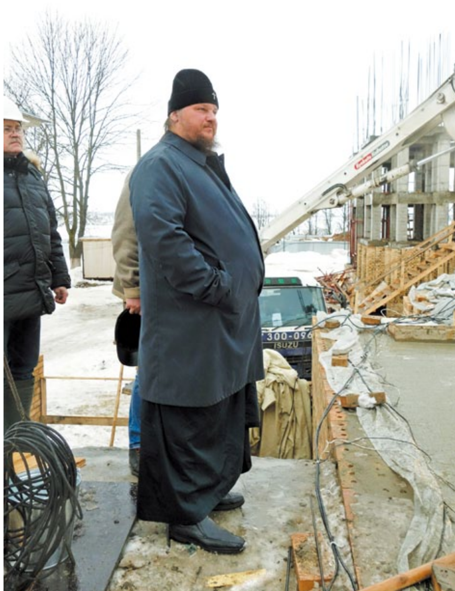
20 февраля 2017 года. Митрополит Костромской и Нерехтский Ферапонт на строительной площадке Костромского кремля.
