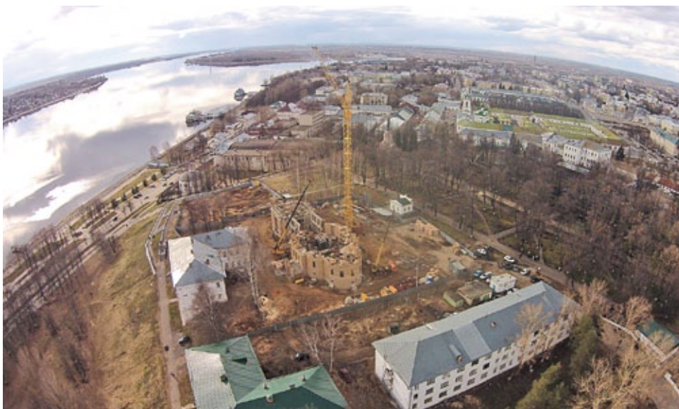
24 апреля 2017 года. Строительная площадка Костромского кремля. Фото выполнено Игорем Алексеевым с использованием квадрокоптера.
