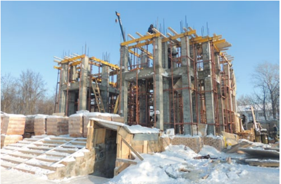
30 января 2017 года. Строящаяся колокольня.
