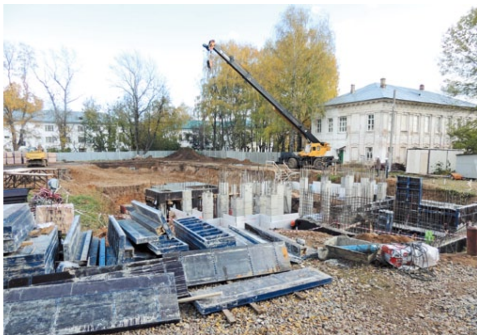
1 октября 2016 года. Строительство колокольни.
