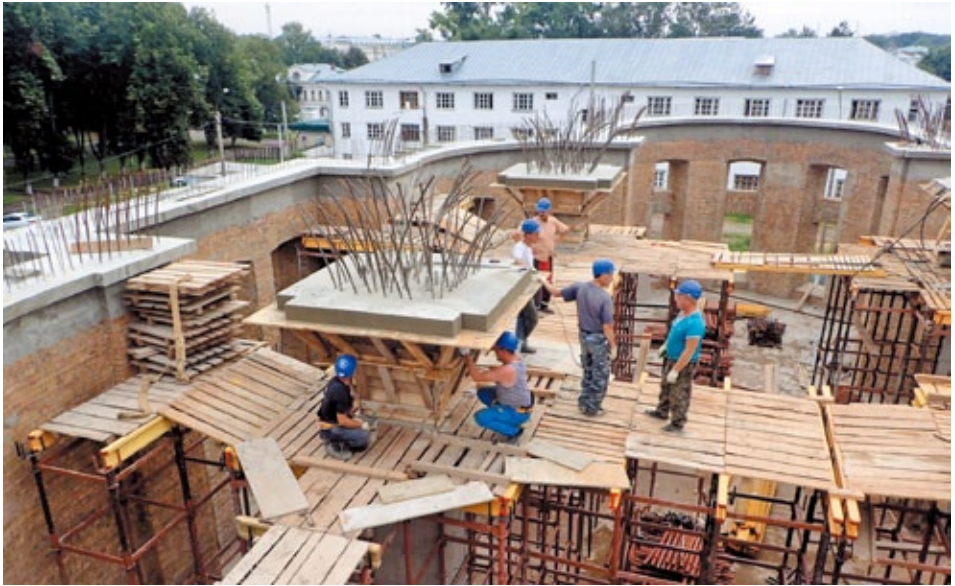
23 августа 2017 года. Строительство Богоявленского собора.
