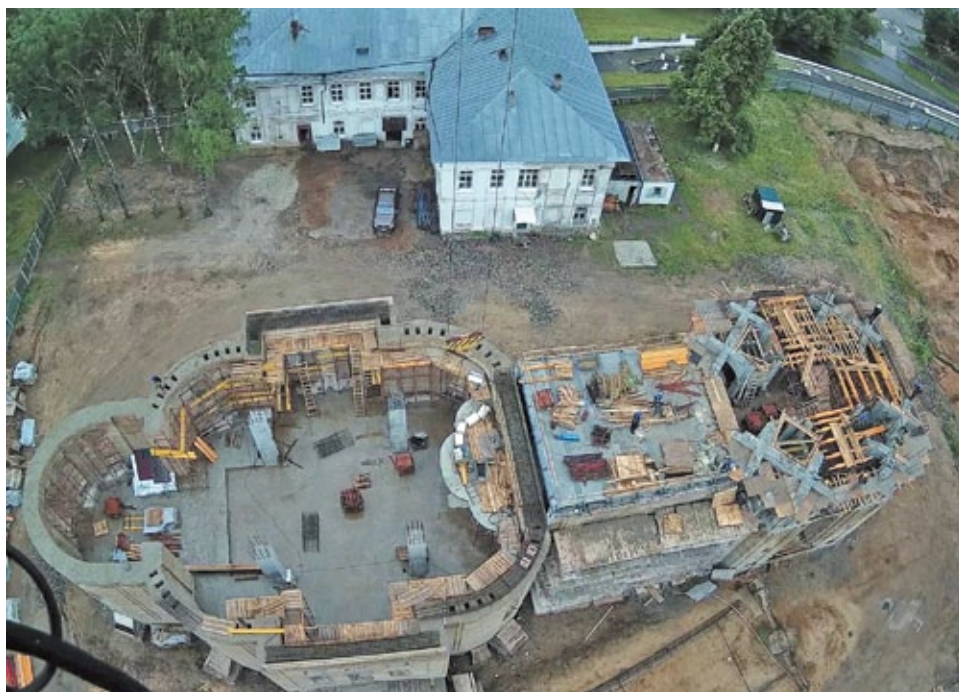
13 июля 2017 года. Вид на строительную площадку с башенного крана.
