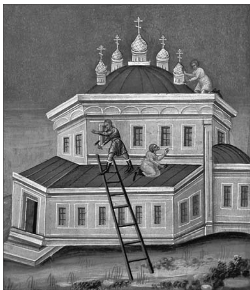
Строительство Успенского собора. Клеймо Феодоровской иконы Божией Матери письма XIX века.
