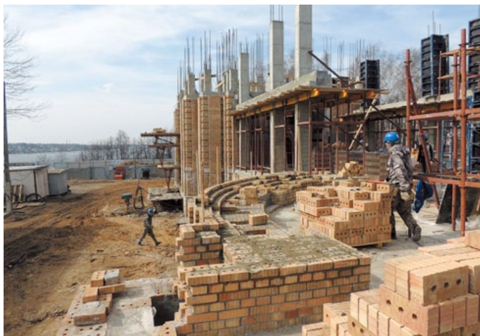
11 апреля 2017 года. Строительство Богоявленского собора.
