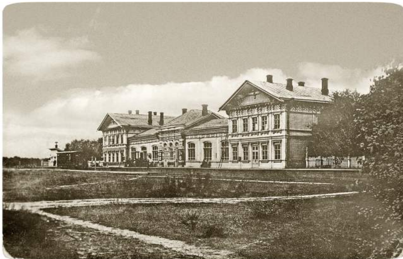
Вид старого железно-дорожного вокзала в Костроме
